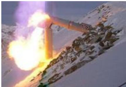
Beim Gazex® System wird die Lawinenauslösung durch Zündung eines Propan-Sauerstoff-Gemisches ( $0.8 \text{ m}^3$  bis  $3.5 \text{ m}^3$ ) erreicht. Somit sind die gesetzlichen Auflagen bezüglich Systembewilligung und Personalausbildung für Handhabung und Bedienung der Anlage gegenüber den Systemen mit Sprengstoff wesentlich einfacher. Ein weiterer großer Vorteil ist die hohe Anzahl an Sprengungen welche mit einer Gasbefüllung durchgeführt werden können. Die Höhe
