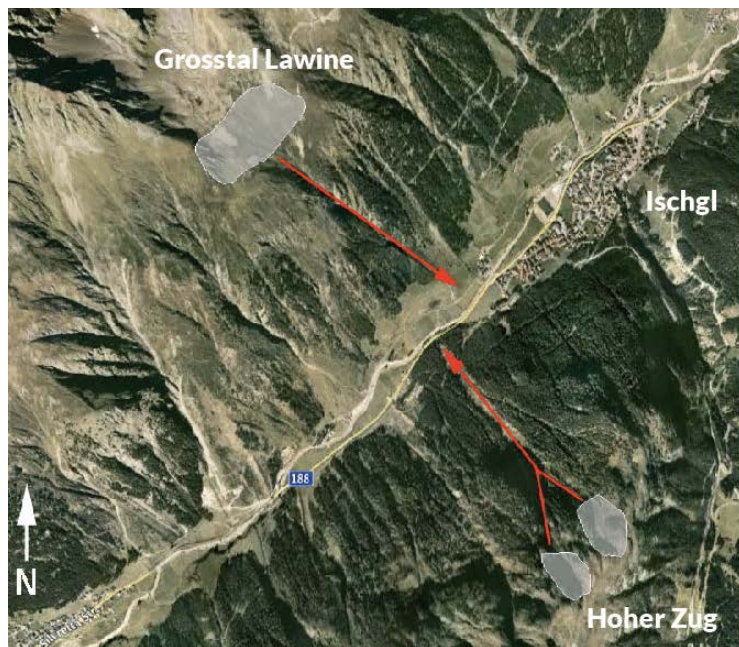
Vue d'ensemble d'"avalanches du Grosstal et de traction élevée" avec la route menacée (Google Earth)
