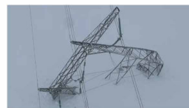
Høyspentmastene er på mellom 30 og 35 meter høye – og havarte med sannsynlig grunnet et snøskred tidligere i uken.
