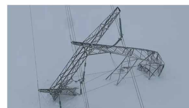
Høyspentmasterne er på mellom 30 og 35 meter høye – og havarerte mest sannsynlig grunnet et snøskred tidligere i uken.
