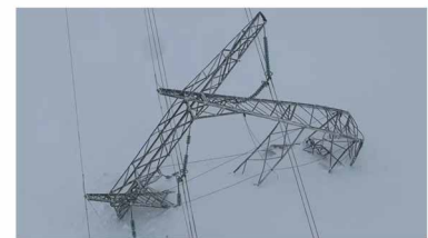
Høyspentmastene er på mellom 30 og 35 meter høye – og havarete mest sannsynlig grunnet et snøskred tidligere i uken.
